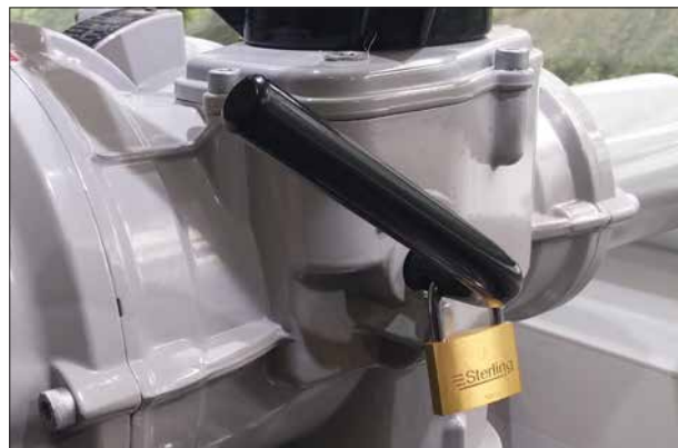
Рис. 7.1. Рычаг включения ручного дублёра IQ3 заперт на висячий замок
